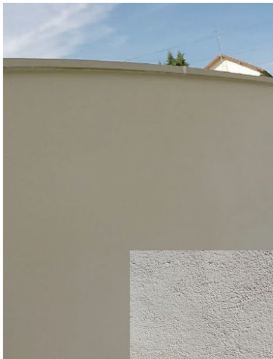
4 5 Mur enduit à la chaux de teinte beige, finition grattée.
