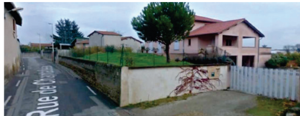
Figure 8 : Parcelle AS75, à droite de la chaussée
