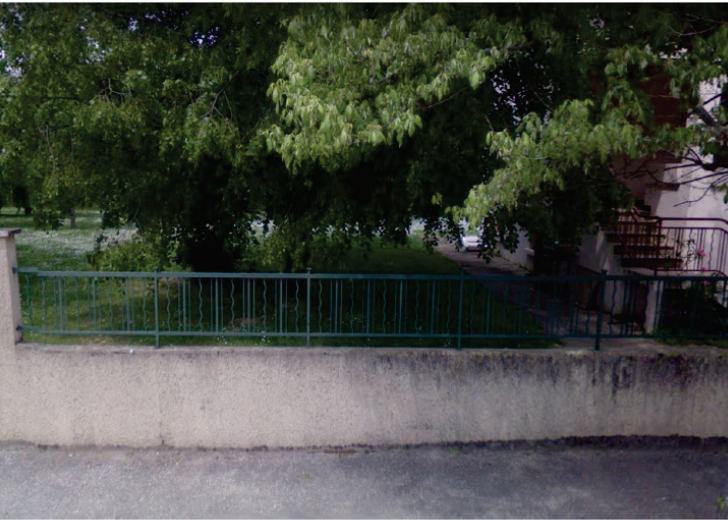
3 Réfection d'un mur à l'identique de l'existant, mur enduit à la chaux de teinte beige et barreaudage clôture de teinte verte.
