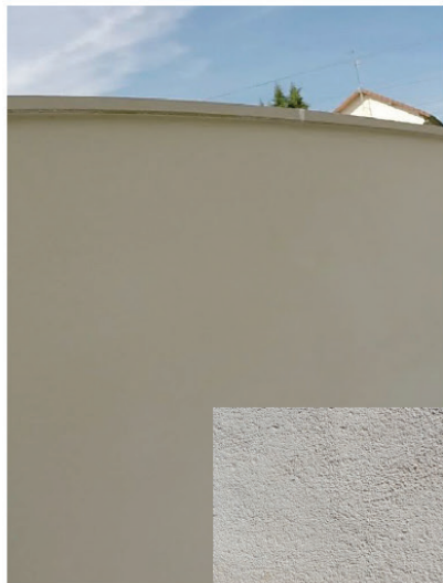
1 2 Mur enduit à la chaux, teinte beige, finition grattée
